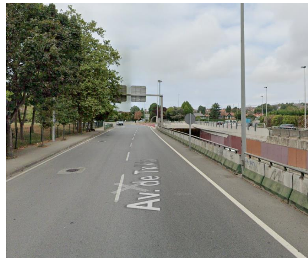
Figura 47: Calzada rotonda-Avanzada afectada en fase de obra
