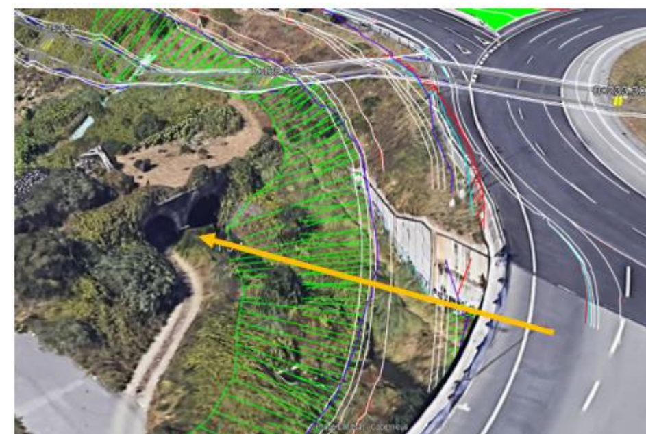
Figura 5: Detalle puente existente
