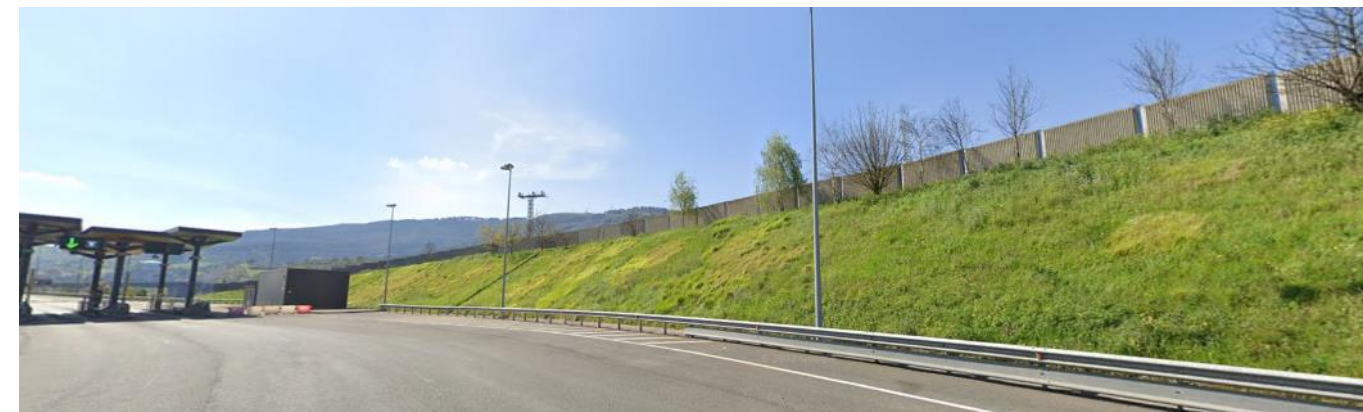
Figura 10: Detalle talud de desmante en borde del peaje de entrada a AP-8 sentido sur.
