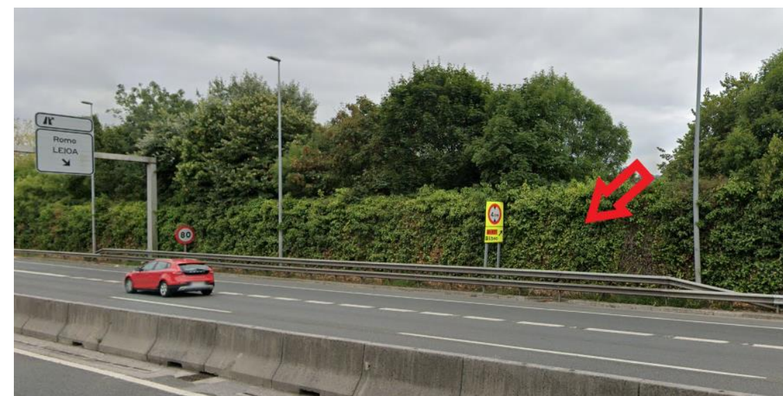
Figura 52: Muro vegetalizado calzada sentido Bilbao
