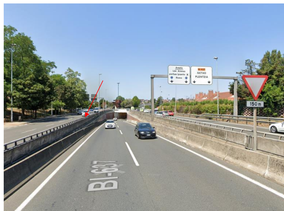
Figura 46: Muros afectados en la ejecución del ramal enterrado Avanzada-Subfluvial
