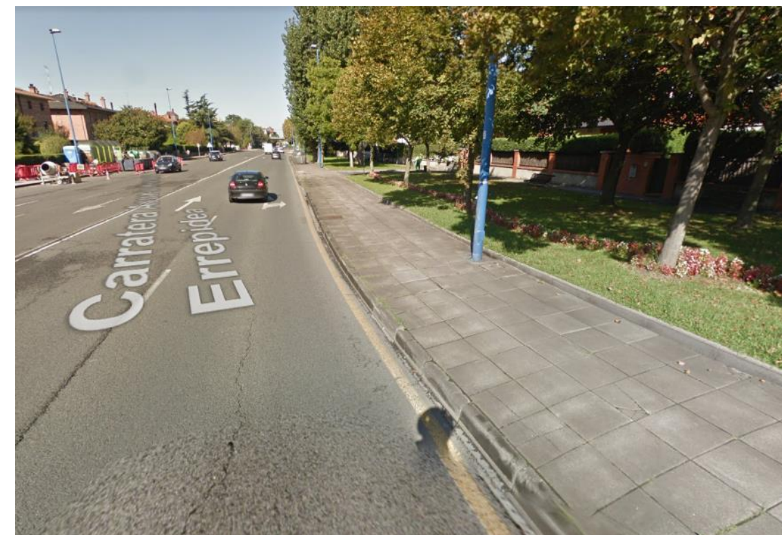
Figura 38: Acera sentido Getxo a eliminar
