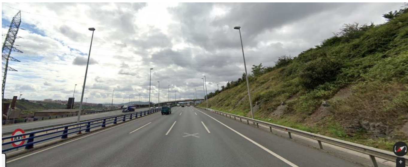
Figura 8: Detalle talud de desmante bulonado existente.
