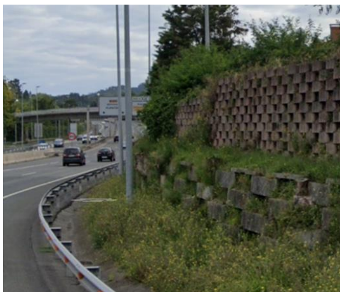
Figura 33: Muro jardinera Uribe Kosta
