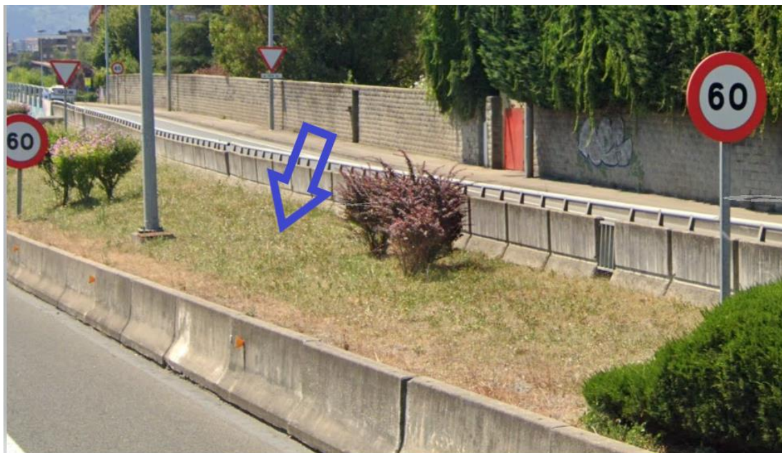
Figura 55: Muro existente tapado actualmente con tierras que se afectará
